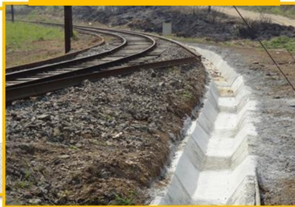
Canaleta moldada em loco km 05
