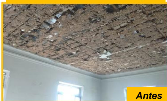
Demolição do forro em estuque
