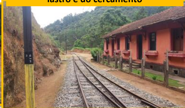
Plantio de grama, recomposição do lastro e do cercamento
